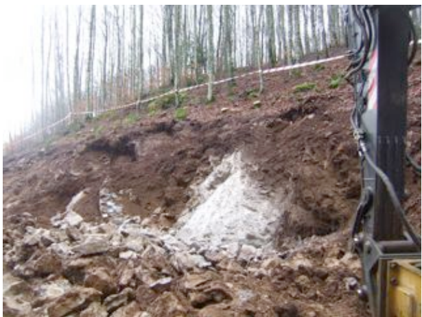
ZILBETI tronçonnage et défonçage
