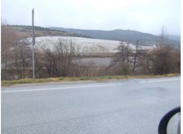
Stockage matériaux usine Magna
