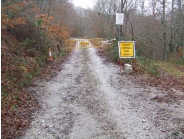
ZILBETI vers le chantier destructeur
